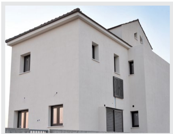
Εξωτερική θερμομόνωση σε ιδιωτική κατοικία στην Κύπρο. Επιφάνεια: 600 m 2
