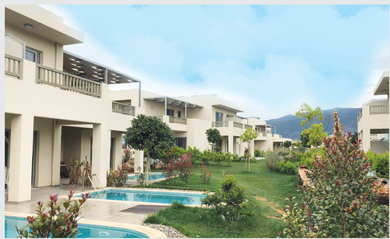
Εξωτερική θερμομόνωση σε νέο ξενοδοχείο στην Καλαμάτα. Επιφάνεια: 2.500 m 2
