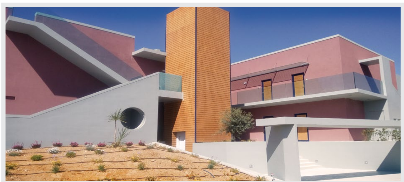
Εξωτερική θερμομόνωση σε ξενοδοχείο στα Χανιά. Επιφάνεια: 2.000 m 2
