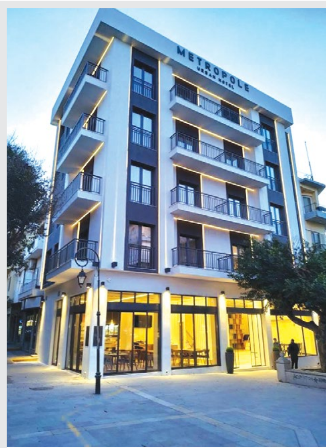
Εξωτερική θερμομόνωση στο ξενοδοχείο Metropole Urban Hotel στο Ηράκλειο Κρήτης. Επιφάνεια: 1.200 m 2
