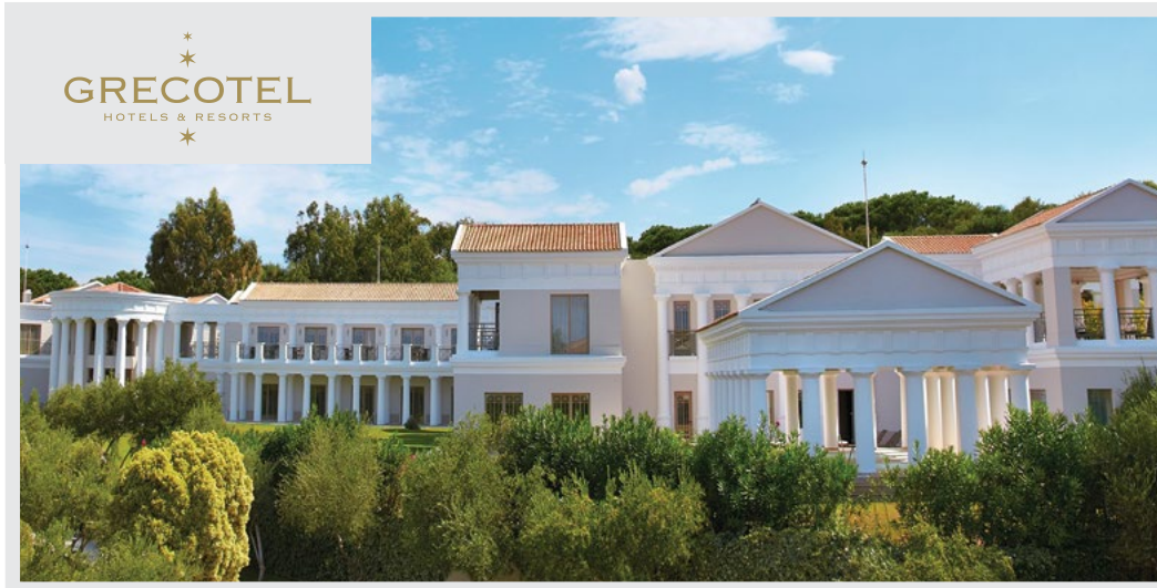
Εξωτερική θερμομόνωση σε ξενοδοχείο στην Πελοπόννησο.
