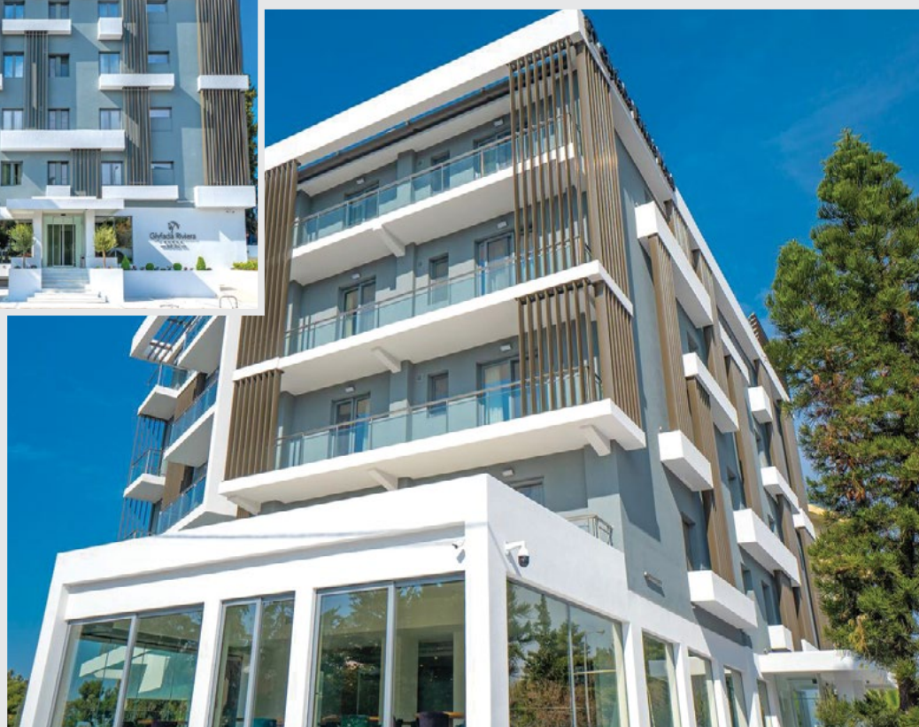
Εξωτερική Θερμομόνωση στο ξενοδοχείο Glyfada Riviera Hotel στη Γλυφάδα. Επιφάνεια: 2.000 m 2
